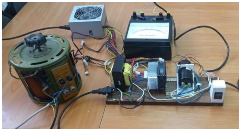
Рисунок 3 – Блок управления скоростью потока в аэродинамической трубе
