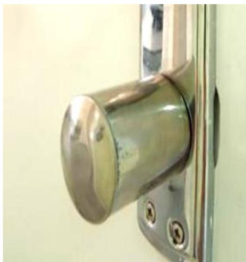
Рисунок 3. Внешний вид корпуса цилиндра замка
